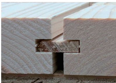
図2 各パネル板の実継(雇い実)
