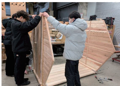
図7 妻側の壁の取り付け
