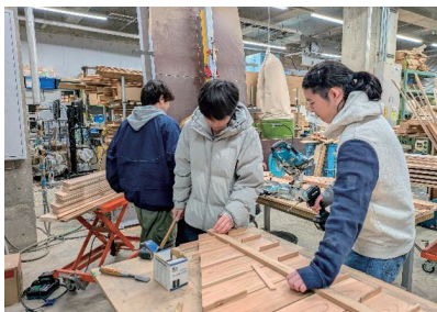
図5 溝部分へつなぎ材を留め付ける
