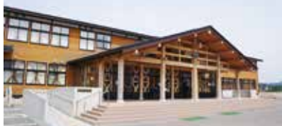
図1 能代市における木造校舎事例 (上: 第四小学校、下: ニツ井小学校)
