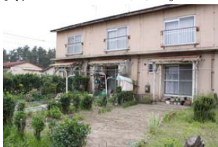
図 1 市営住宅-外観
