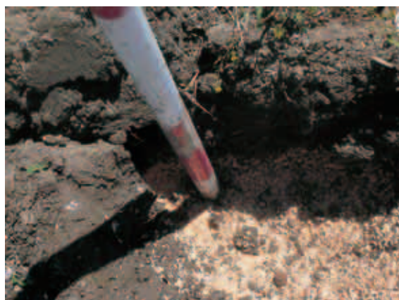
写真 2-3 籾殻補助暗渠に充填される籾殻
