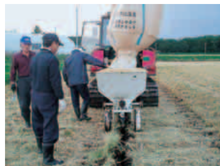
写真2-1 籾殻補助暗渠作業
