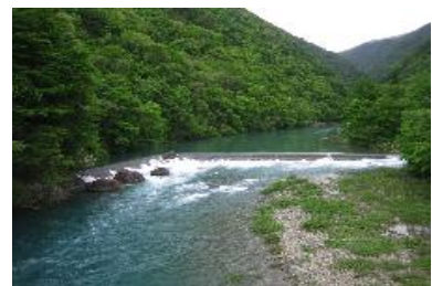
農業用水を取入れる頭首工調査
