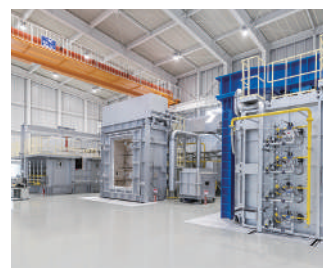
耐火試験棟の内部
