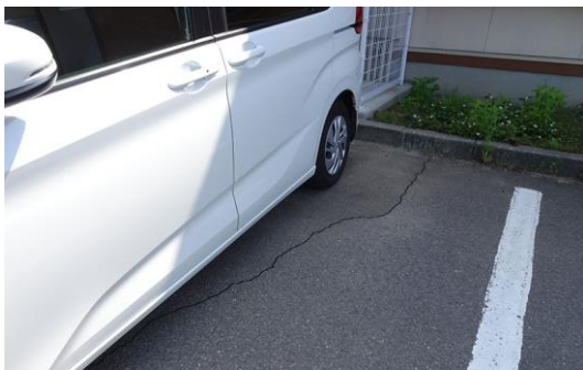
敷地周辺地盤のひび割れ
