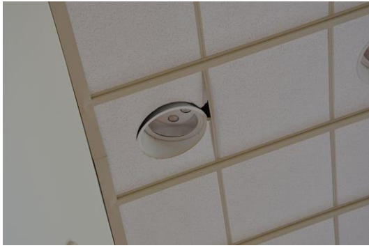
照明機材廻りのパネル損傷
