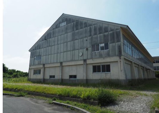
屋内運動場外観
