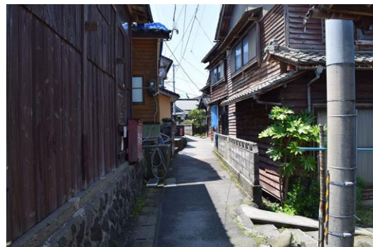
木造住宅の被害状況（小路）
