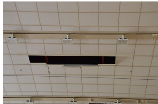
天井パネル落下箇所
