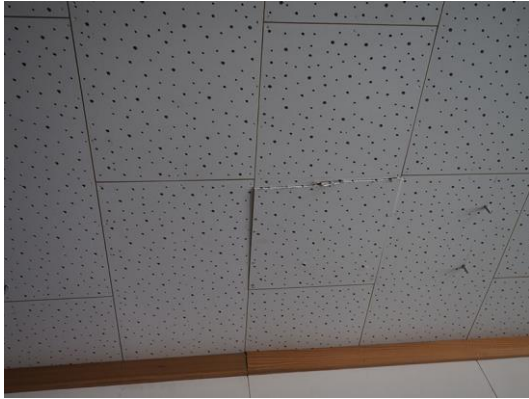
天井パネルの損傷
