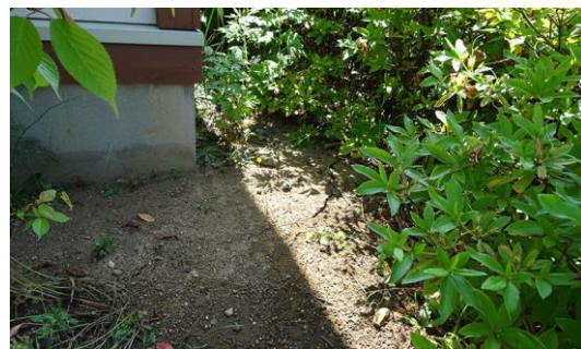
敷地周辺地盤のひび割れ
