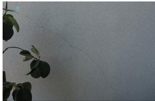
1階ロビー壁面のひび割れ
