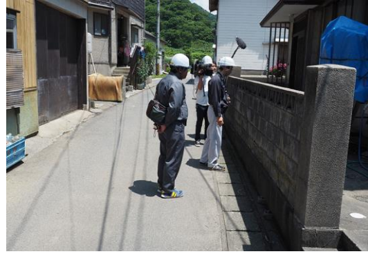
ブロック塀の傾斜
