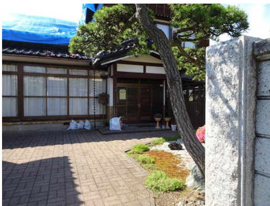
屋根瓦の損傷, 落下
