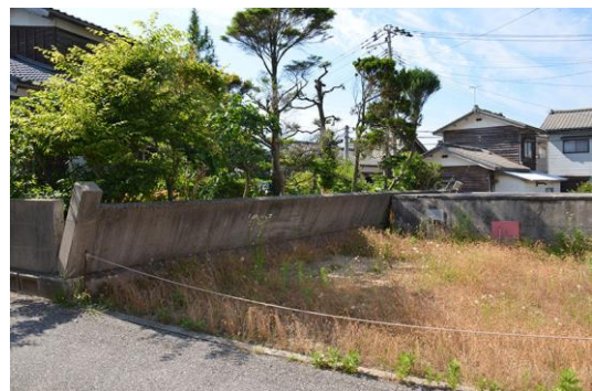
コンクリート塀の傾斜
