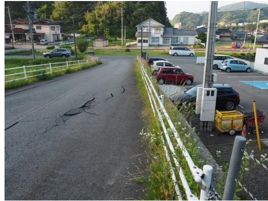
アスファルト路面の損傷
