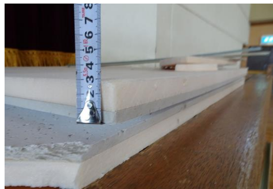
落下した天井パネル
