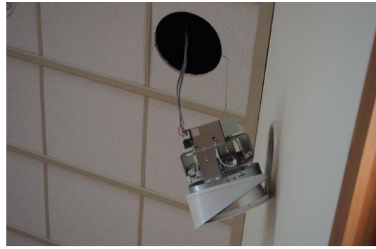
照明機材の落下
