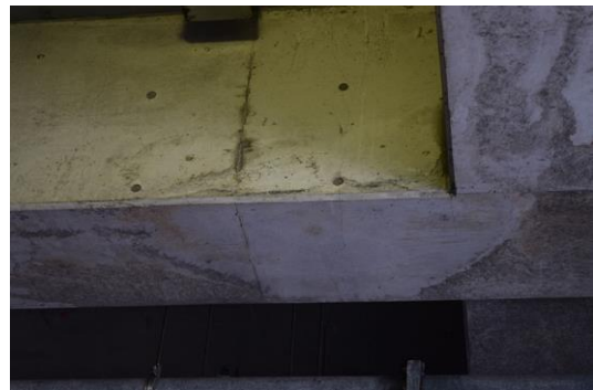
梁端部のひび割れ
