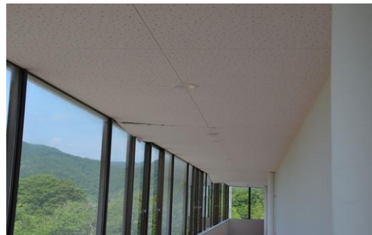
北側2階出窓部分の損傷
