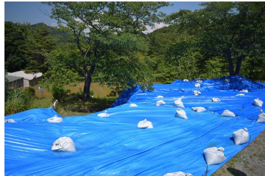
敷地法面の崩壊
