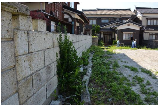
大谷石塀の損傷
