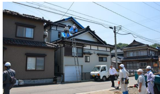
屋根瓦の損傷，落下
