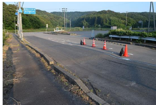
アスファルト路面の損傷
