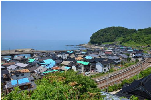
木造住宅の被害状況（西光寺山より）
