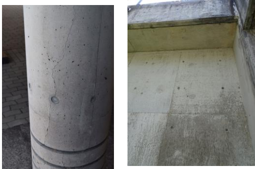
柱・壁仕上げのひび割れ
