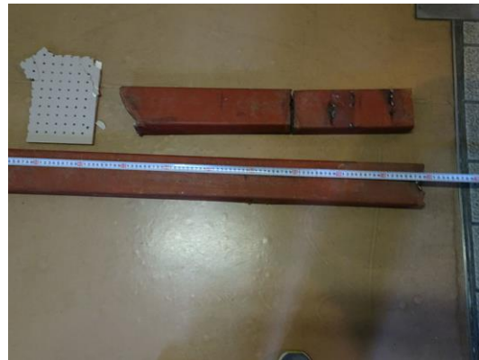
落下した軽量鉄骨
