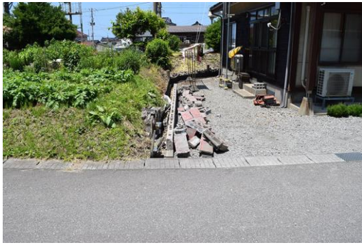
ブロック塀の損傷
