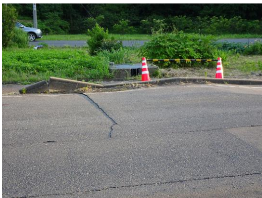
アスファルト路面の損傷
