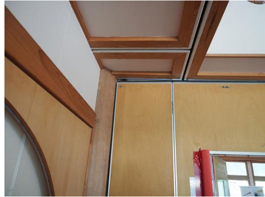
建具と構造部材との隙間進展
