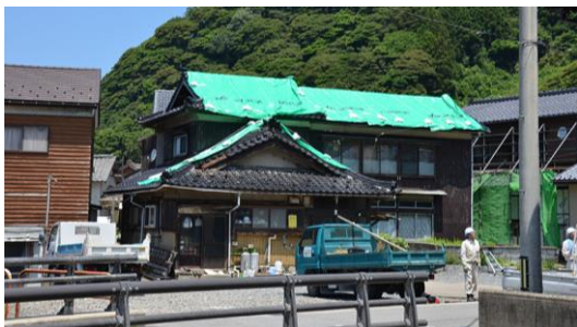
屋根瓦の損傷，落下
