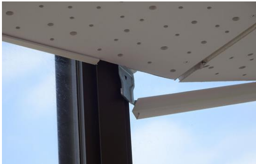
北側2階出窓部分の損傷
