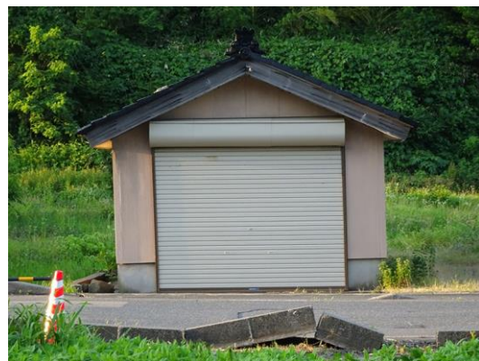
地盤変状により傾斜した建物
