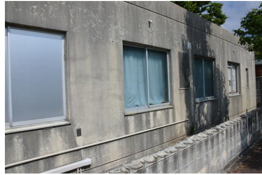
窓ガラスの損傷
