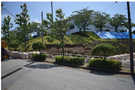
敷地法面の崩壊
