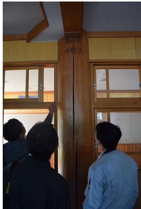
柱干割れの進展
