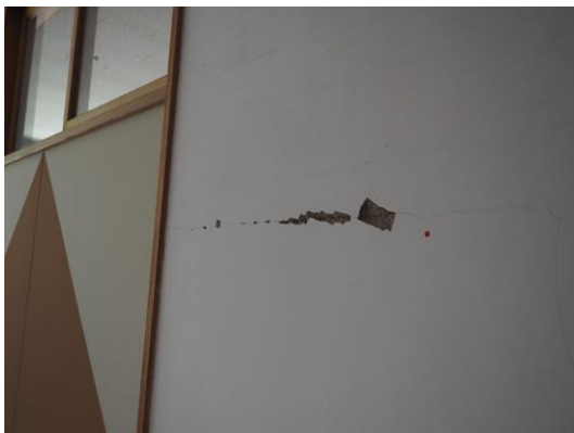
漆喰仕上げのひび割れ
