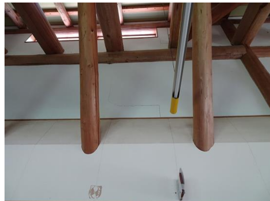
漆喰仕上げのひび割れ
