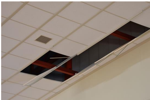
天井パネル落下箇所
