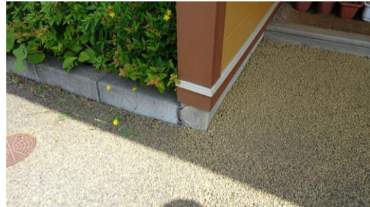
基礎立ち上がり部の損傷
