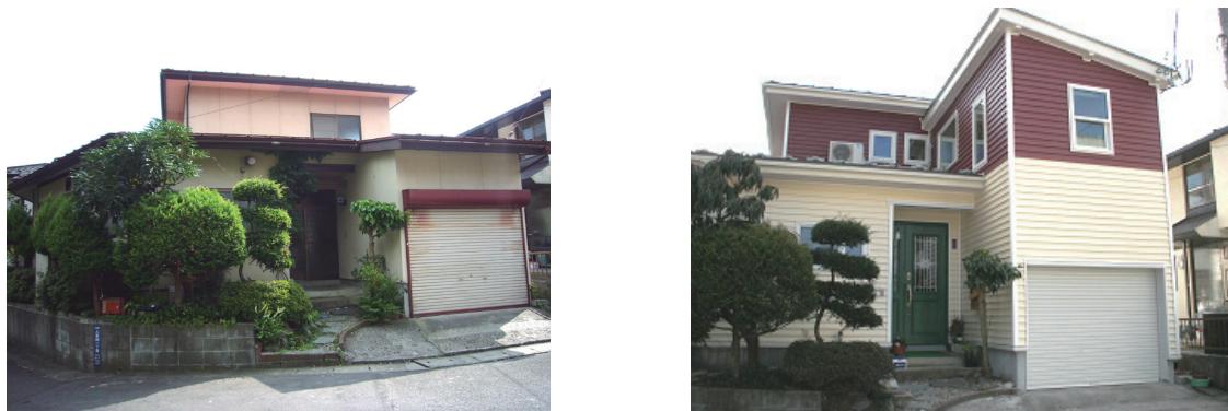
写真 調査対象住宅の北側外観（左：改修前，右：改修後）
