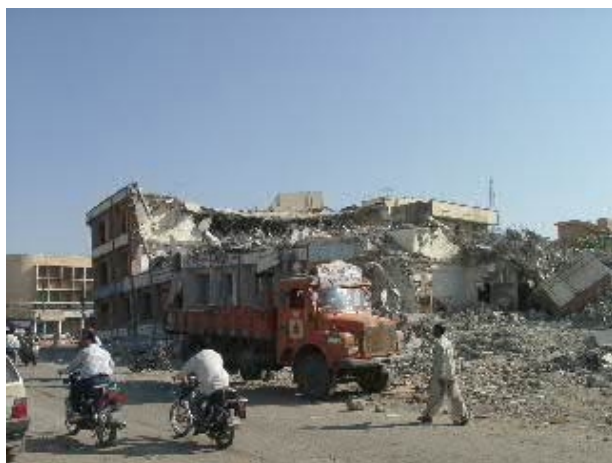
写真 24 半分が倒壊したビル
