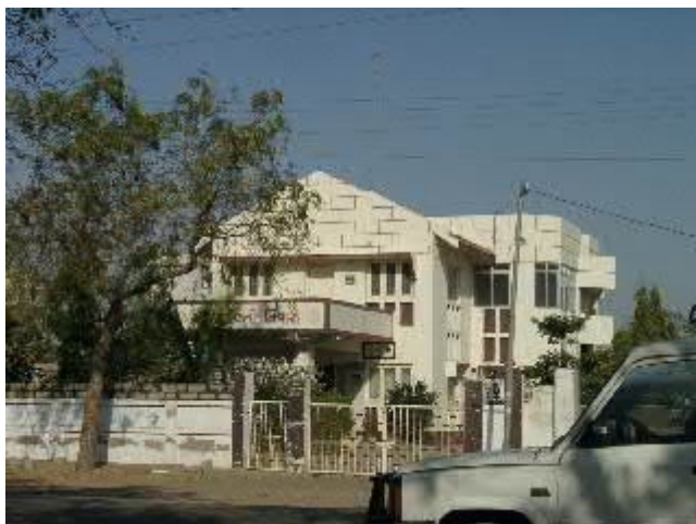
写真 21 比較的被害が軽微な住宅
