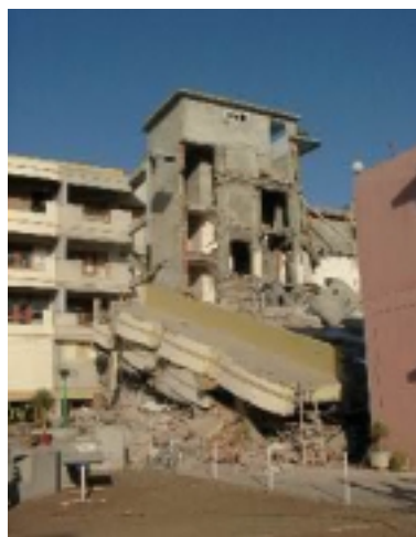
写真 27 同 倒壊した部分
