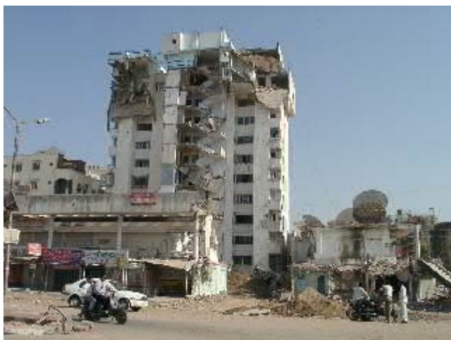
写真 3 Maneshi Complex (市街西部)
