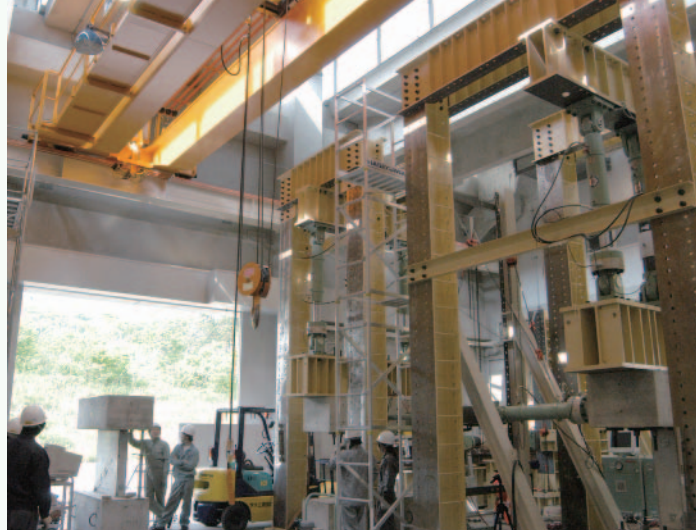
特別実験棟の大規模構造実験設備
