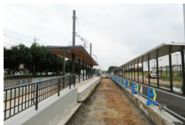
※宇都宮市 LRT 建設中の様子
