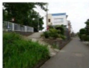
No.6 傾斜がきつい避難経路
