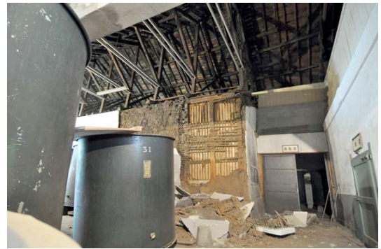
図1 土蔵の被害状況
