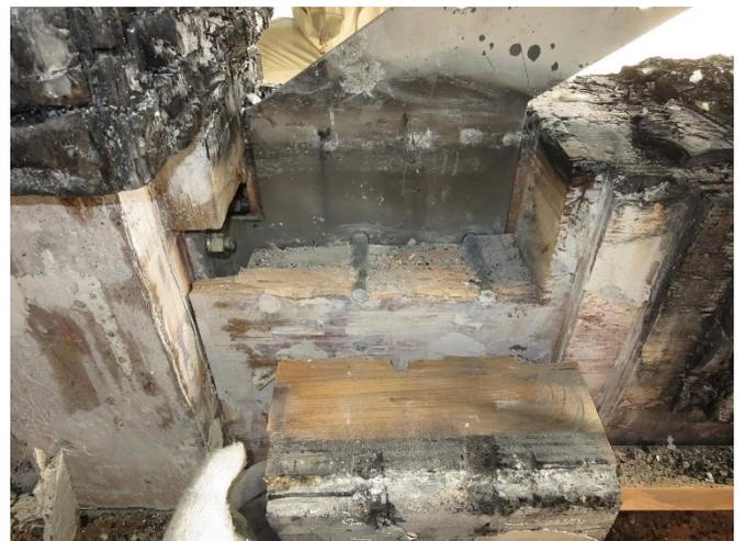
写真 50 B部接合部：柱・はり・筋交い接合金物
