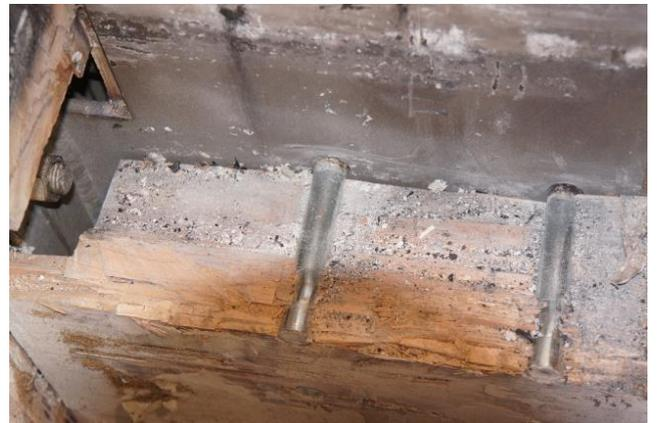
写真 5-3-6 接合 B: 軸組金物
