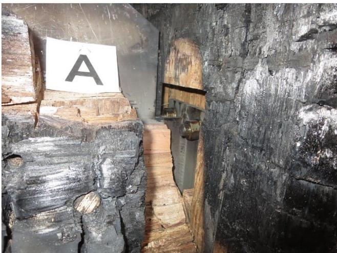
写真 43 A 部接合部：柱・はり・筋交い接合金物
