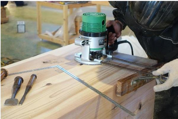
図 3-10 手加工によるスリット部の座掘り
