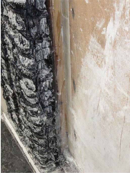
写真 35 B部接合部：壁・柱取合部の状況
