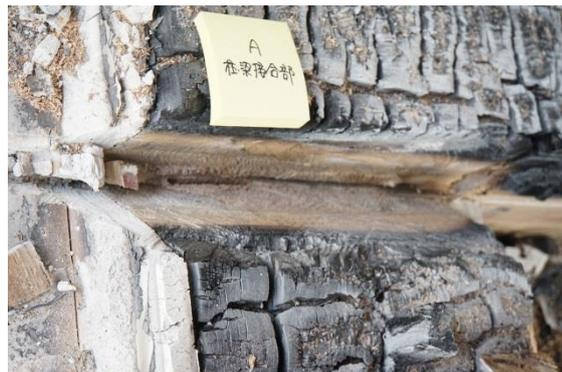
写真 5-1-13 A 柱梁接合部 切断面
