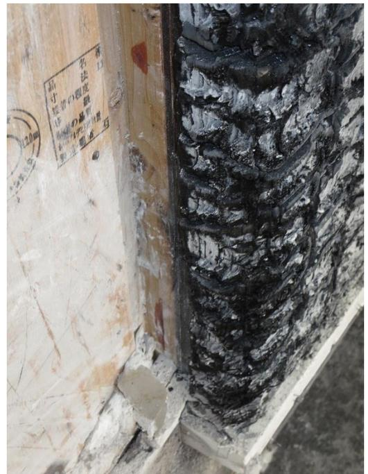
写真 34 B部接合部：壁・柱取合部の状況
