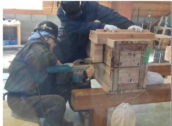
図 3-11 手加工によるスリットの刻み
