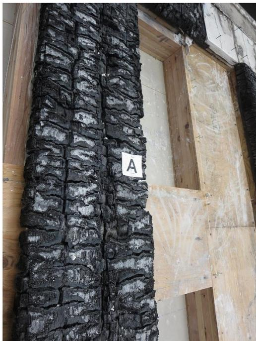
写真 25 A部接合部：柱の状況
