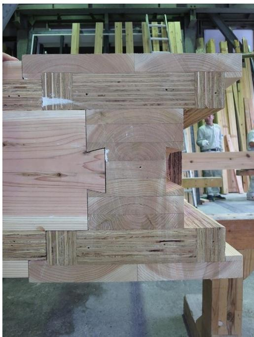
写真3 A部接合部接合状況（柱上面）
