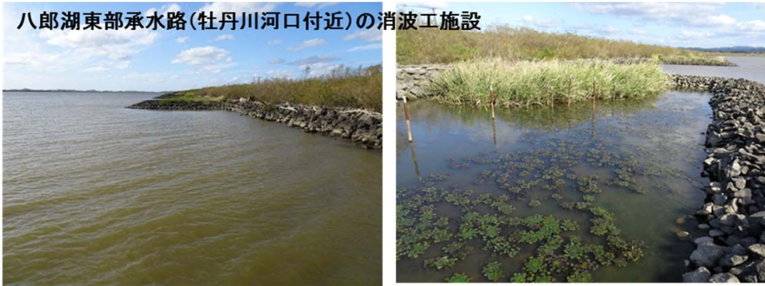
消波工内外の水生物調査
